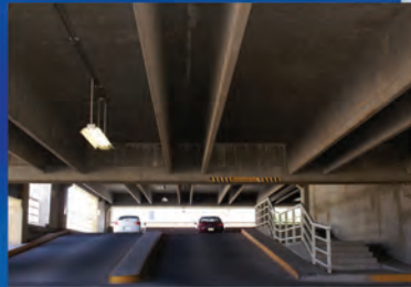
Dobles-T, Trabes y Columnas
